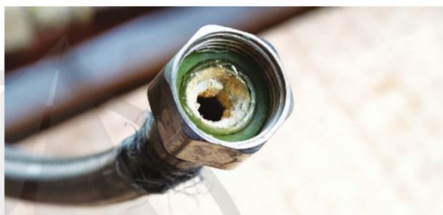
Hình 19.1. Một đoạn ống nước bị đóng cặn
